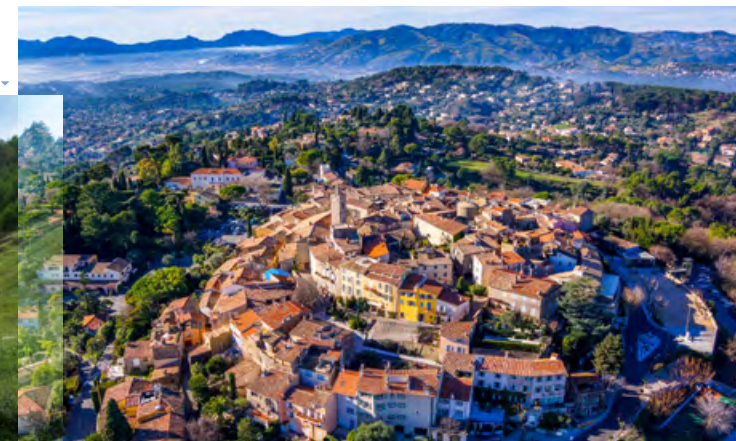
Mougins vue aérienne - OT Mougins
